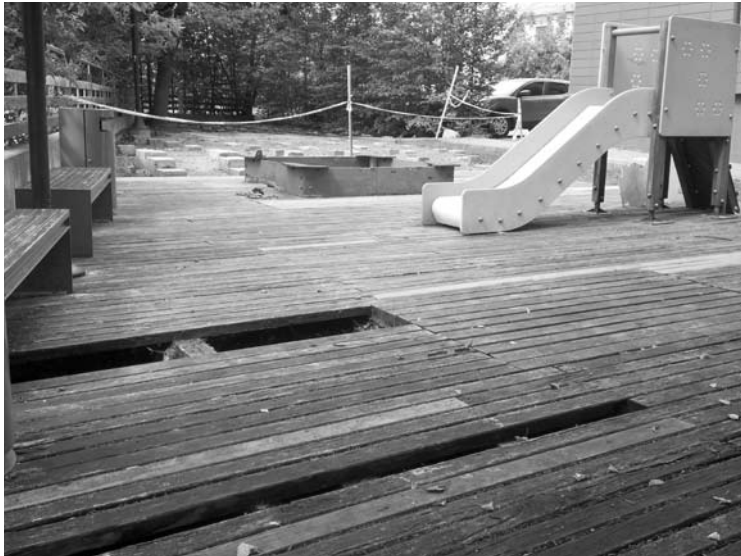
Palikta medinė vaikų žaidimų aikštelės danga tokia sutrūnijusi, kad užlipus žmogui bet kada gali įlūžti.
